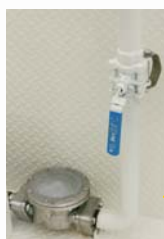
Vanne d'isolement ø 40 Clapet anti-siphon
