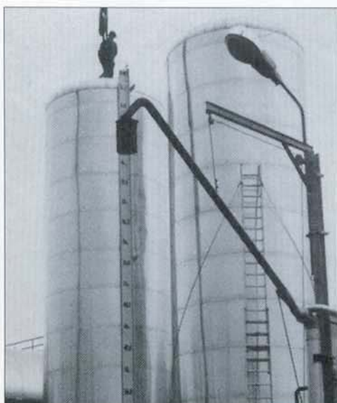
Stockage de goudrons et bitumes à l'usine COLAS d'Airvault (79).
